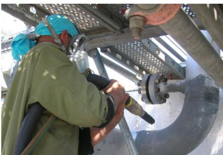
Das Sponge Jet System kann überall eingesetzt werden, wo eine optimal vorbereitete Oberfläche durch Sandstrahlen gewünscht, jedoch dies wegen der drohenden Staubbelastung nicht durchgeführt werden kann. Es können weniger effektive Technologien wie Eisstrahlen, Elektro- oder mechanische Werkzeuge, Hochdruck-Wasserstrahlen und Schlammstrahlen mit Sponge Media Strahlverfahren ersetzt werden. Es stehen diverse Strahlmittel, die bis zum Polieren von Edelstahlflächen reichen, zur Verfügung.
